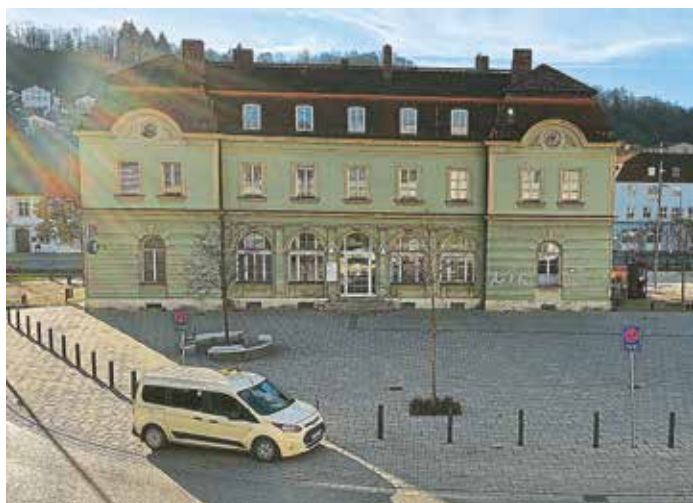
Wird in 2026 eine Großbaustelle: der Stadtbahnhof.
