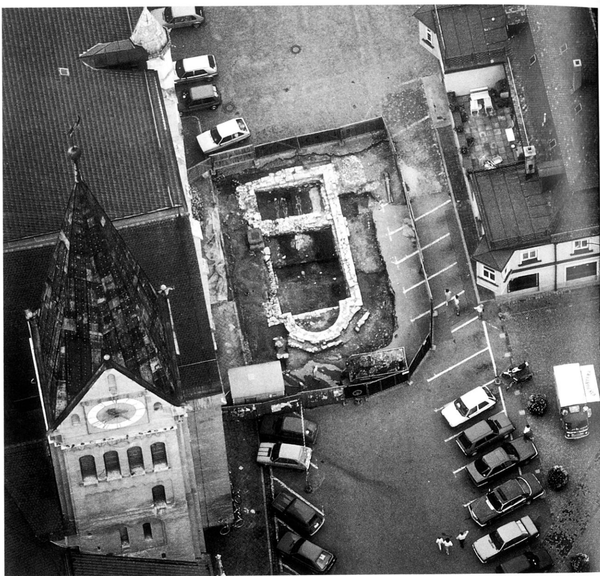
Luftbildaufnahme der Fundamentmauern der Nikolauskirche.
