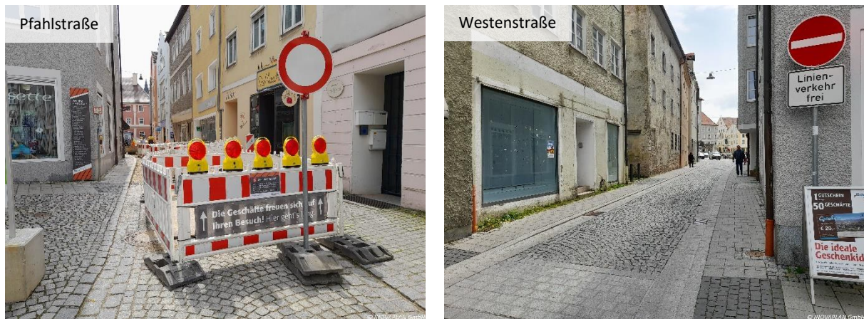
Abbildung 5 Baustellenbedingte Sperrung der Pfahlstraße (Quelle: INOVAPLAN GmbH)
