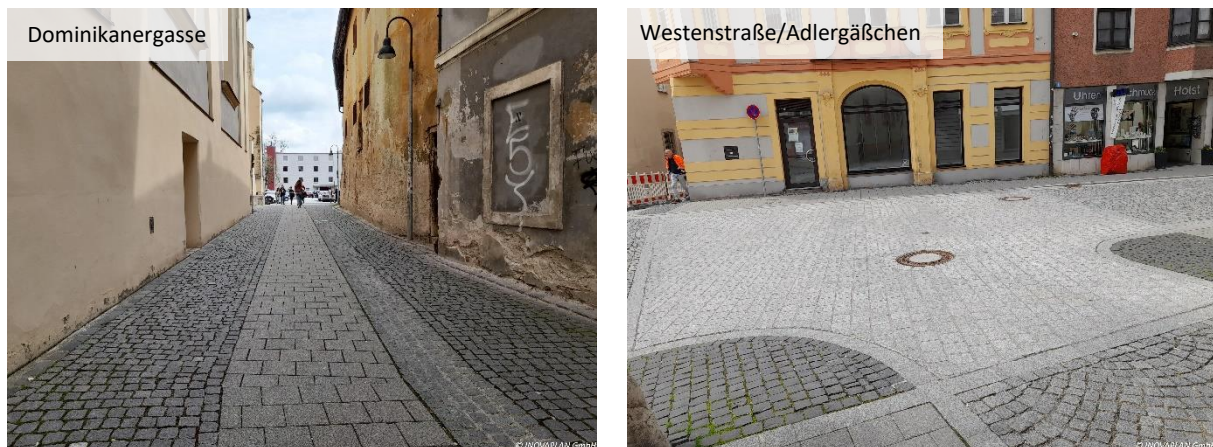
Abbildung 19 Laufband und Knotenpunktgestaltung aus großformatigem Pflaster (Quelle: INOVAPLAN GmbH)
